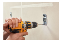
Geberit montageplaat enkel 2 schroeven
