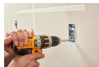
Cadre de montage Geberit Deux vis seulement
