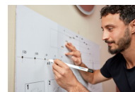
Geberit installatiesjabloon gestandaardiseerde boorposities
